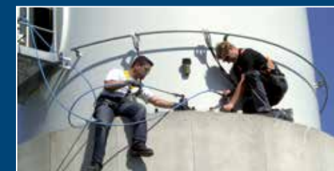
Anchor bolt tests Ankerbolzenprüfung
