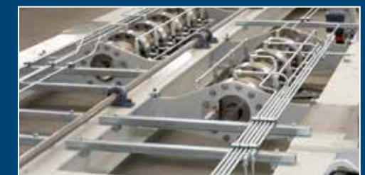
Hydraulic assembly on site Hydraulikmontage vor Ort
